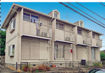
S63年1月完成・鉄骨2階・全8室・総合補償要・東京都町田市金井ヶ丘2
